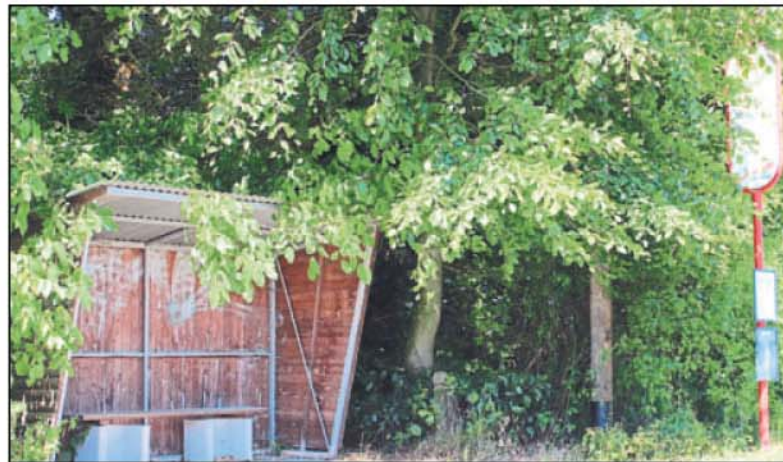
Auch die Schmiererein im Warthehäuschen an der Düttingdorfer Straße haben die Männer versucht, zu beseitigen.
