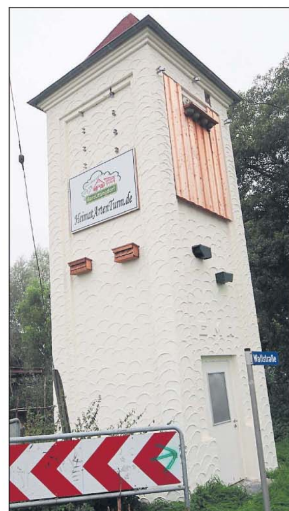
Dieses ehemalige Traföhäuschen an der Düttingdorfer/Ecke Wallsraße ist zum Heimat-Arten-Turm umgebaut worden. Foto: Gerhard Hülsegg
