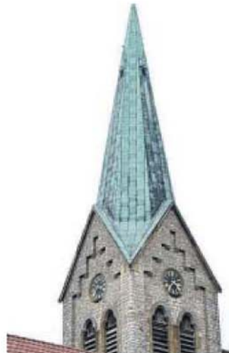
Grünes Dach: Die Kirche St. Anna in St. Annen.
