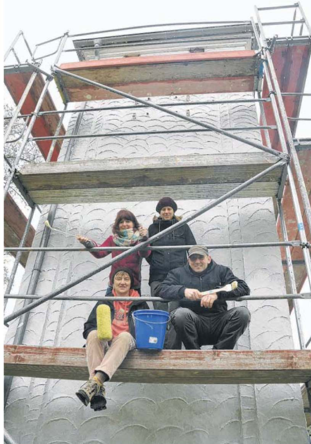
Frische Farbe: Im Dezember erhielt das alte Trafohäuschen in Bardüttingdorf einen neuen Anstrich, Monika Storm, Jörg Gumpert (vorne v. l.), Iris Westermeier und Yvonne vom Hofe (hinten v. l.) waren mit Pinseln und Eimer aufs Gerüst geklettert.
