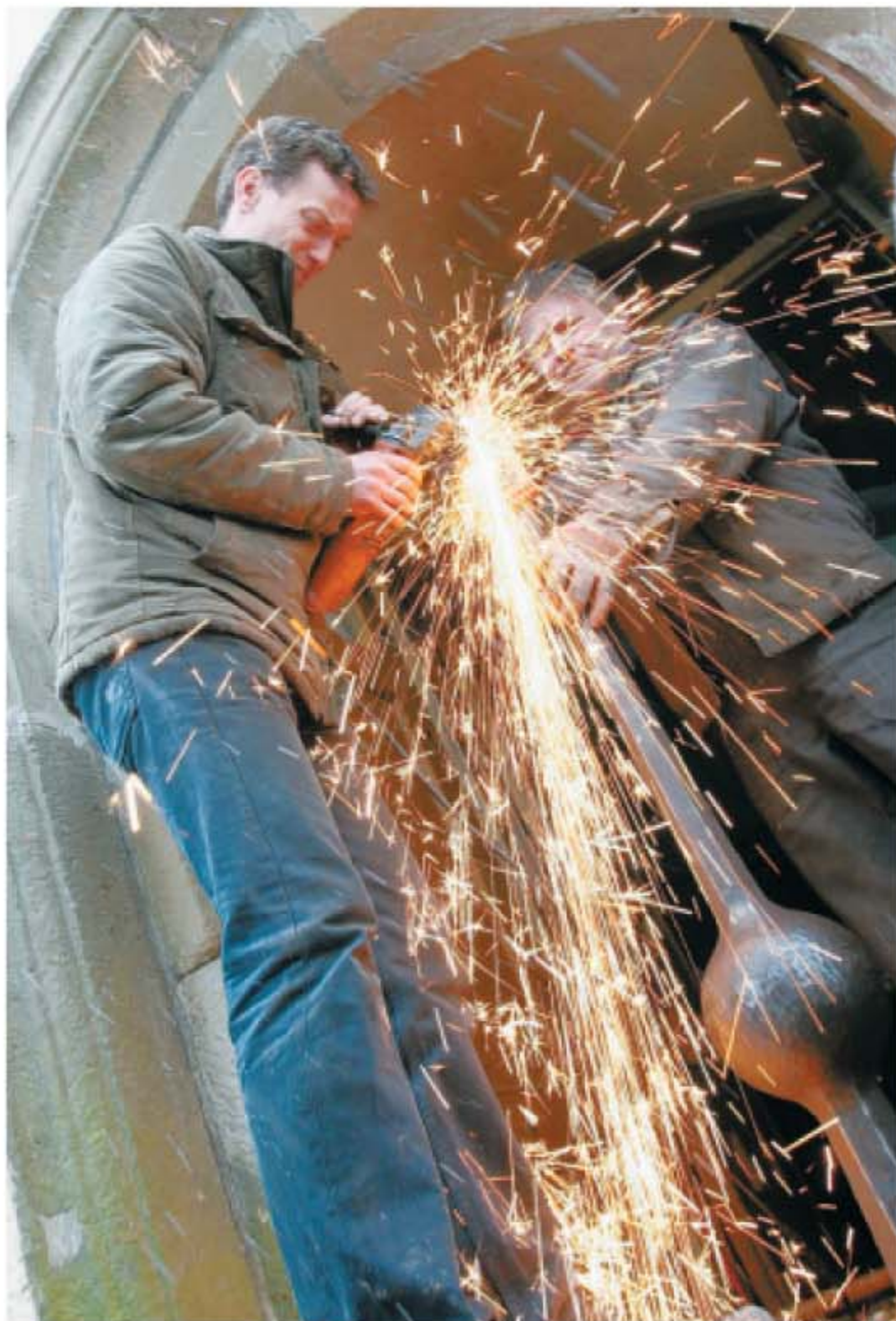
Funkenflug: Mit der Flex bringen Sebastian Otto (l.) und Albert Becker die Metallgewinde am oberen Klöppelende auf Länge.
