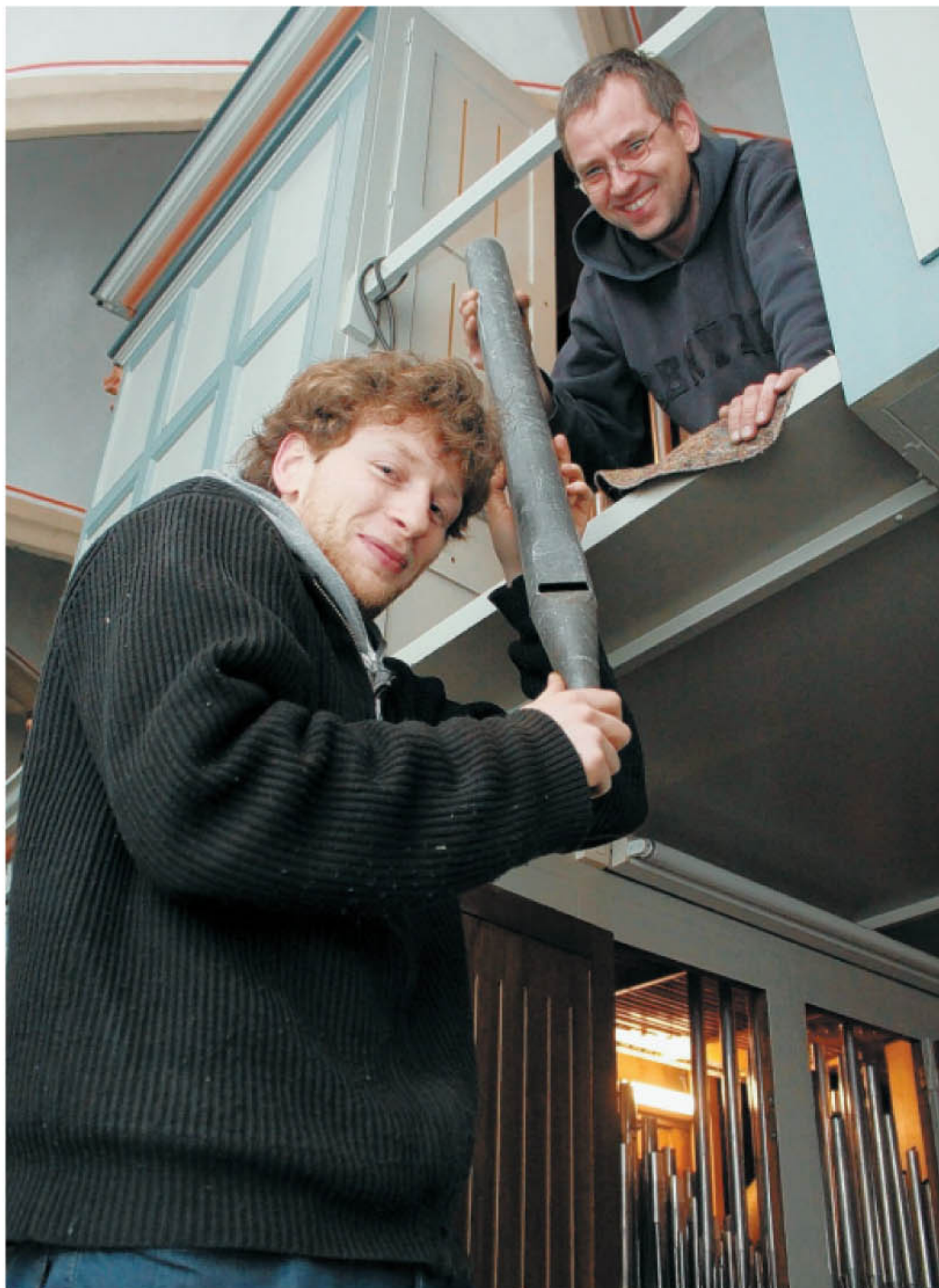
Ausbau: Zwei Fachleute der Orgelwerkstatt Wegscheider aus Dresden, David Großmann (l.) und Friedemann Schwarzenberg (oben) bauen Stück für Stück die historischen Bleipfeifen aus der Wallenbrücker Orgel aus.
