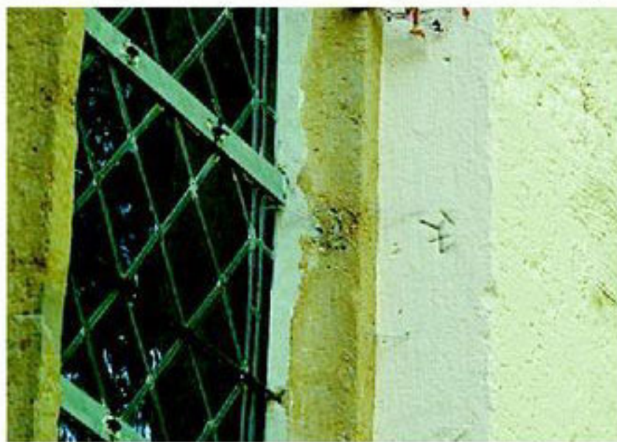
Kennzeichen: Anhand der Steinmetzzeichen können Fachleute heute ablesen, wer wann am Bau von Baudenkmalern beteiligt war. Dieses Zeichen findet sich in einer Fensterleibung der Kirche.
